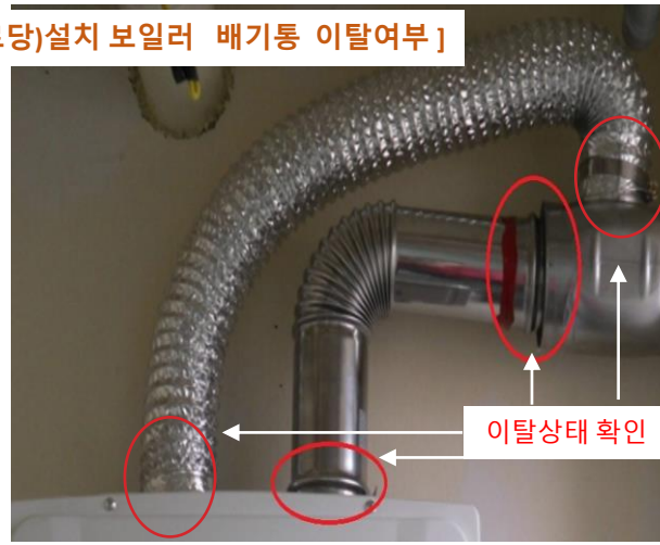
[공동주택 공유시설물(관리사무실, 경로당)설치 보일러 배기구 외부충격으로 손상 여부]
