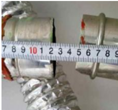
[공동주택 공유시설물(관리사무실, 경로당)설치 보일러 배기통 이탈여부]
