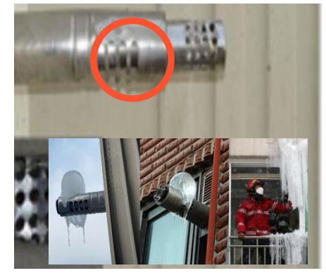
[공동주택 공유시설물(관리사무실, 경로당)설치 보일러 배기구 외부충격으로 손상 여부]
